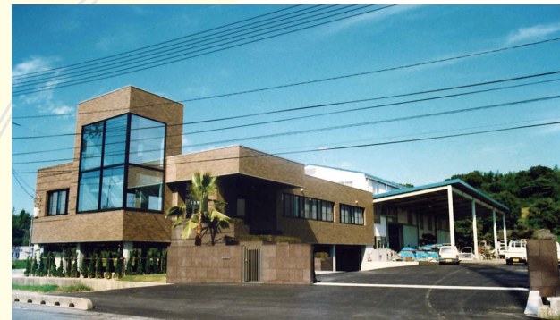
中村建設株式会社 本社・資材センター
